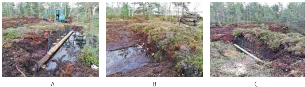
174. attēls. Kūdras aizsprosti un to būvniecība Laugas purvā. Foto: G. Šusts.
