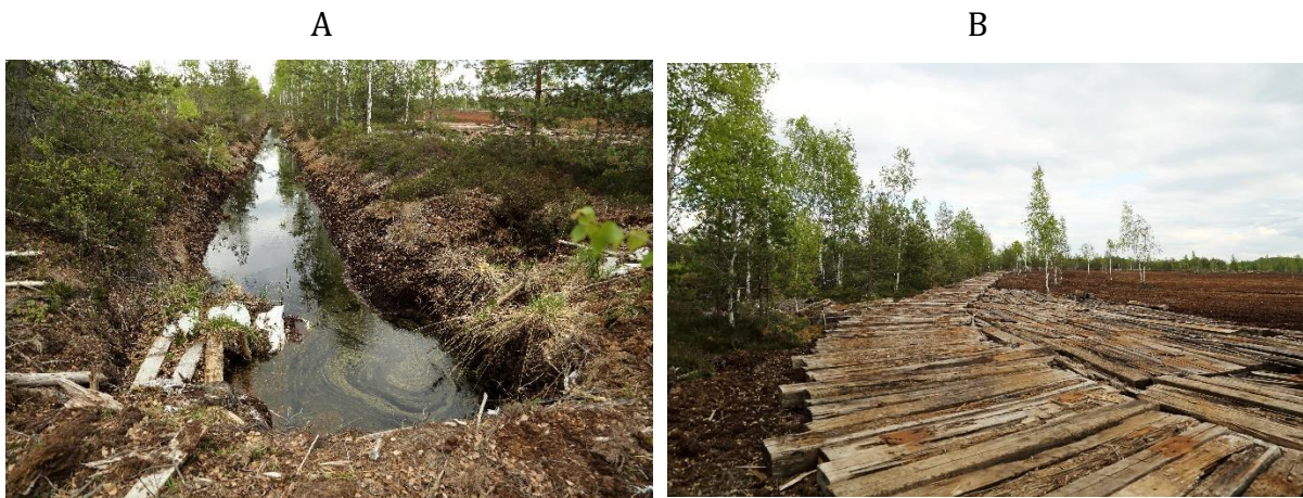
30. attēls. A- plānotais dambējamais grāvis; B- dzelzceļa sliežu gulšņu ceļš gar kontūr grāvja labājo krastu (Foto: Māra Pakalne)
